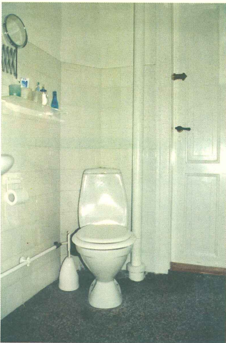
Eksisterende badeværelse i en ejendom fra århundredskiftet før ombygning. Der er hvide fliser, terrazzogulv og alle rør synlige. Fotos: Kurt Johansen
