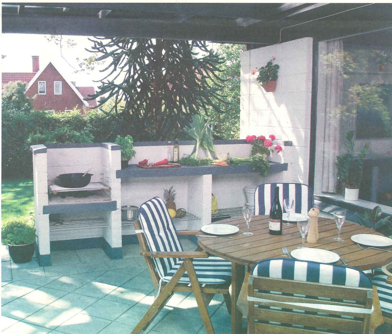
Udekøkkenet er designet af Abita. Det er etableret i forbindelse med ny flisebelægning på den overdækkede terrasse. Opbygningen er i gasbeton, som svarer til husets facade. En vind- og vejrbestandig løsning, der samtidig skaber læ på terrassen. Fra stuen er der vinduesvæg i hele terrassens længde, og udearealet er en synlig og integreret del af boligarealet.
