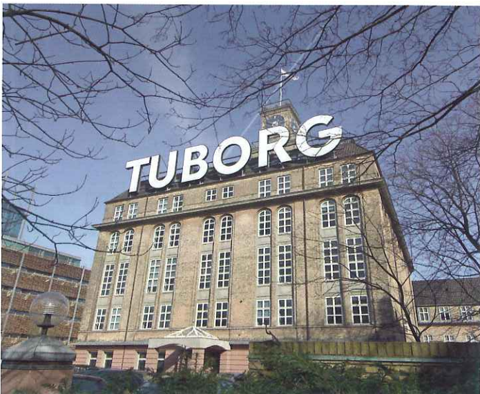
Strandvejen 58 i Hellerup er den tidligere mineralvandsfabrik fra 1923, tegnet af arkitekten Svend Risom.
