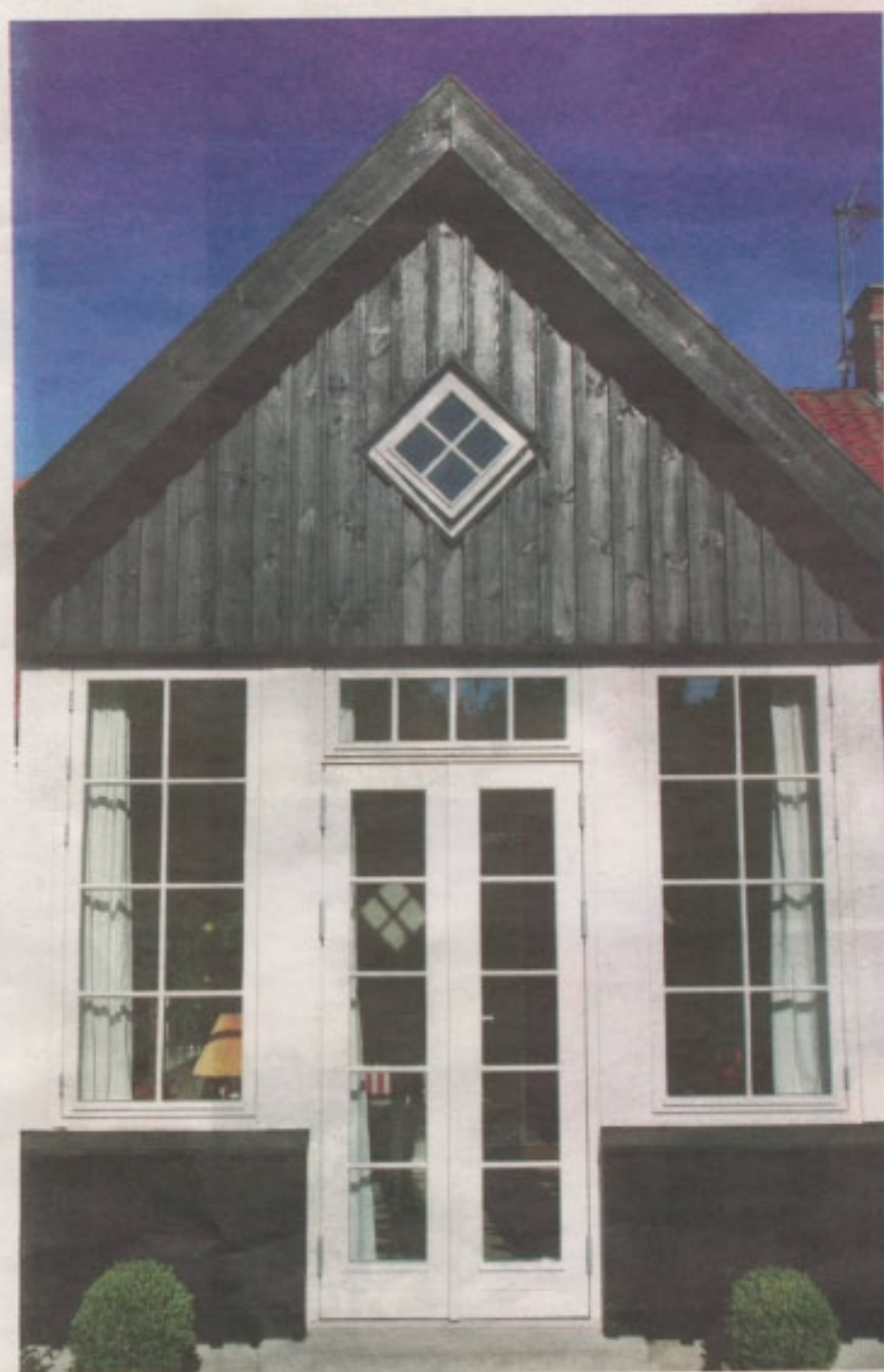
Myrna Havn har selv tegnet havestuen med sortmalet trægavl og hvide småsprossede ruder. Den er opført i 2008 og passer perfekt ind i husets stil.
